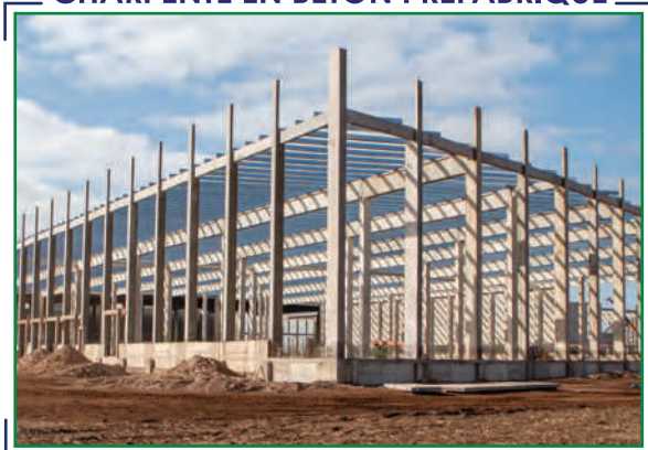
CHARPENTE EN BÉTON PRÉFABRIQUÉ
