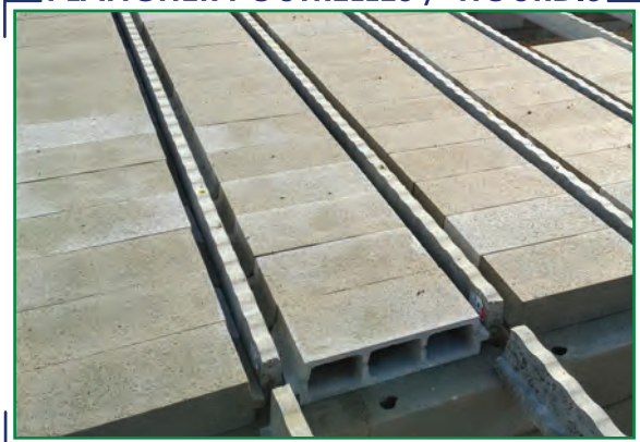
PLANCHER POUTRELLES / HOURDIS
